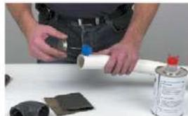
Enduire d'une couche uniforme et régulière, d'abord sur l'entrée de l'emboîture puis sur la totalité du bout mâle, en terminant, dans le sens longitudinal.
