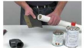
Bien dépolir avec du papier de verre le tuyau et le raccord, puis nettoyer les deux parties avec le décapant.
