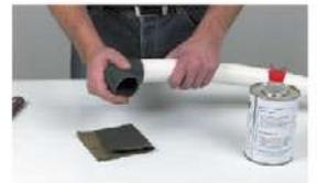
Emboîter à fond jusqu'au repère initialement tracé. Eliminer les excédents de colle, ne pas contraindre à l'assemblage pendant 2 mn pour le rigide et 3h pour le tuyau souple. Mise en pression 24h après.
